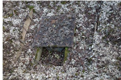
Puits d'exploration surmonté par un couvercle non étanche fermé par un cadenas
