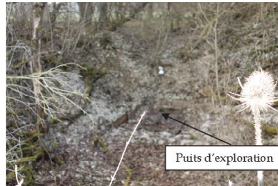
Puits d'exploration surmonté par un couvercle non étanche fermé par un cadenas
